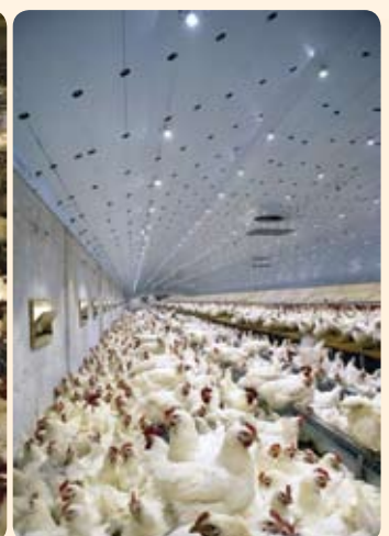
Ledes világítási rendszer brojler szülőpárokna
